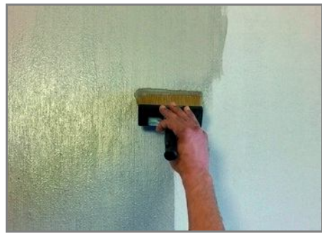
Paso 4 - Distribuya el producto verticalmente en la pared para mantener y dibujar el efecto fluido de FilidiSeta
